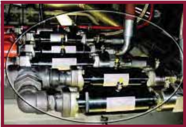
在有限的安装空间里，这六个消声器在泵的出口处，平行的安装着。
